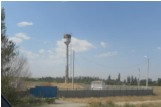
Фото 14 - Водонапорная башня в новой школе
