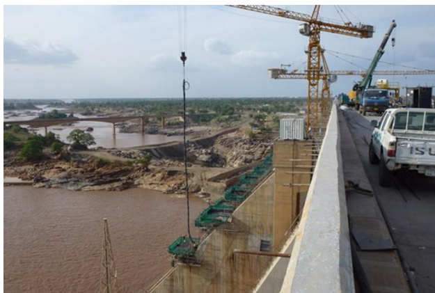
Рисунок 5-20 Повышение плотины Розейрес ( http://pf.bbrnetwork.com/ )
