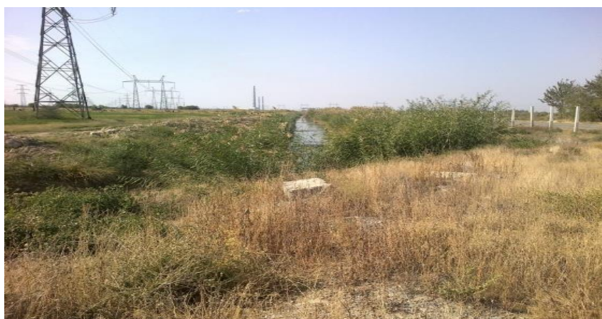
Фото. 2. Состояние КДС в Зафарабадском районе
