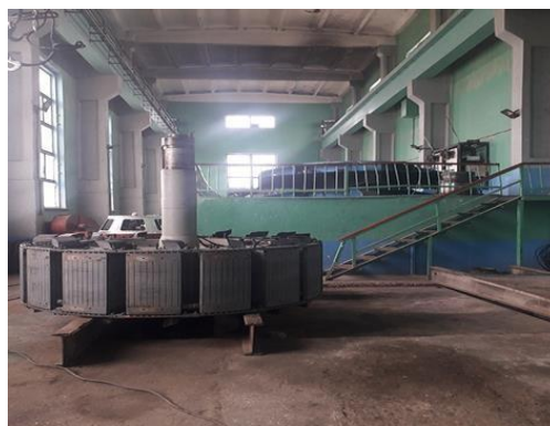
Фото. 5. Вышедшие из строя агрегаты насосные станции КВ-1 (слева) и Пахтакор (справа)
