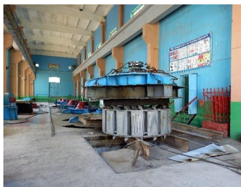
Фото. 5. Вышедшие из строя агрегаты насосные станции КВ-1 (слева) и Пахтакор (справа)
