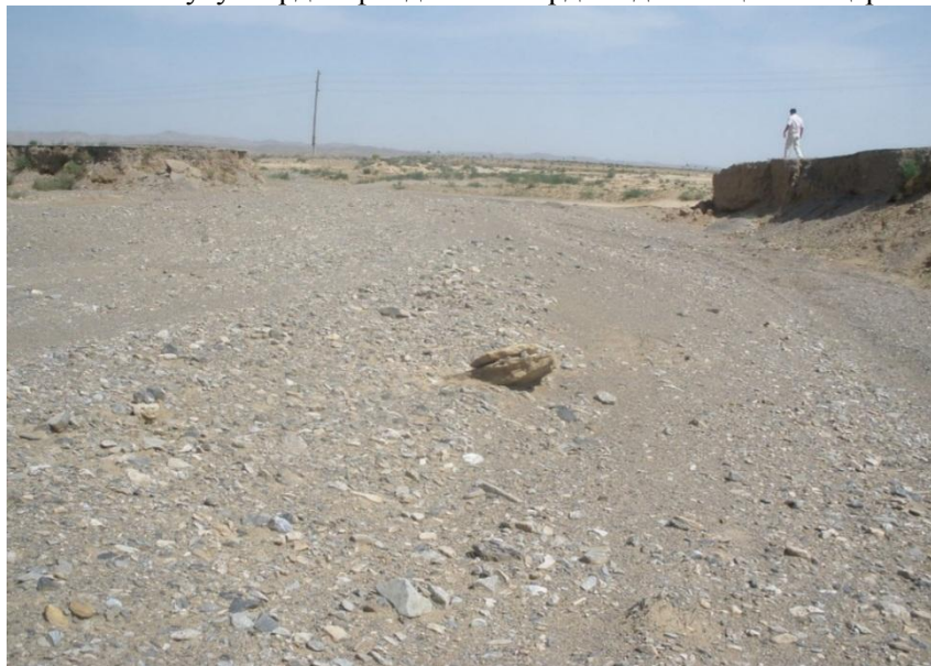
2-расм. Қулжуктов тизмаси этакларидан ўтадиган Бухоро-Жонгелди йўлининг сел оқими ювиб кетган қисми (2012 йил 26 апрель)
