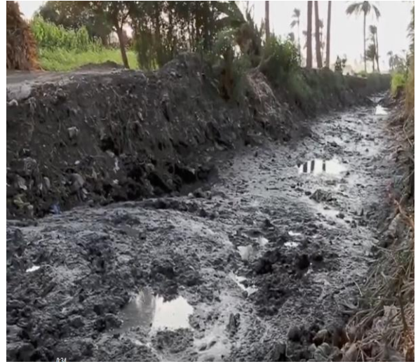
Рисунок 3 – Последствия неконтролируемого потока оросительной воды
