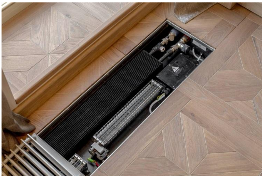
Рисунок 2 – Устройство внутripольного конвектора
