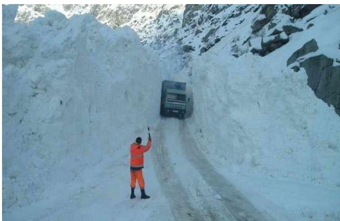
Рисунок 1. Схода снежных лавин на автодороги Душанбе - Худжанд
