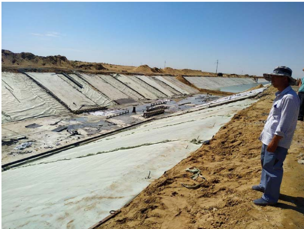
Фото: Бетонирование канала Бустан
