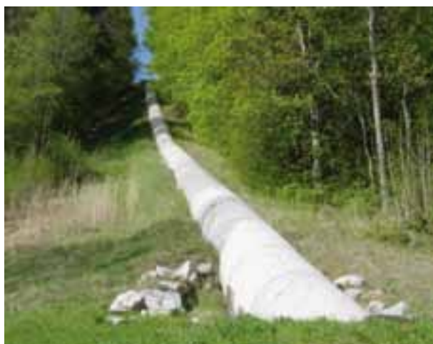
Рисунок II.4.21. Пример частично заглубленного напорного трубопровода
