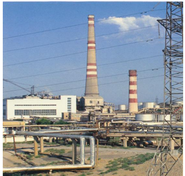
Тепловая электростанция в г. Туркменбаши
