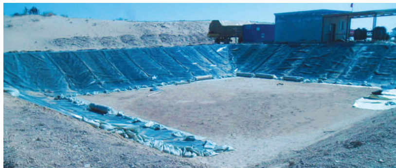
РИСУНОК 5 СТРОИТЕЛЬСТВО БАССЕЙНА СУТОЧНОГО РЕГУЛИРОВАНИЯ
