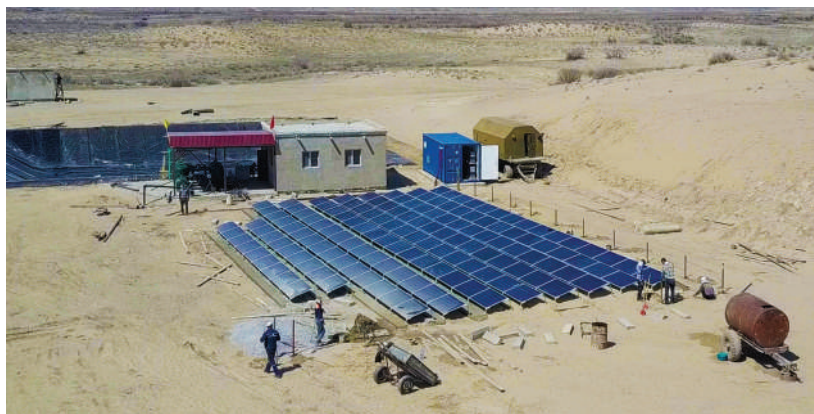
РИСУНОК 14 УСТАНОВКА СОЛНЕЧНЫХ БАТАРЕЙ
